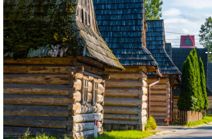
Zabytkowa zabudowa w Chochołowie
